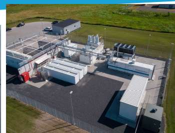
HyBalance, Taani, 1,2 MW elektrolüüs, kütuseelement ja el.võrgu tasakaalustamine, 2018 a
